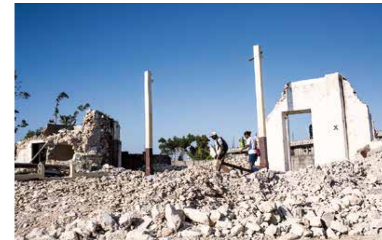
Zerstörte Kirche in Grand Vincent, Haiti, nach Hurrikan Matthew 2016.
