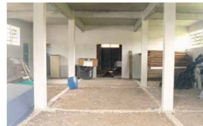
Das neue Bildungszentrum „Dom Ivo Lorscheiter“ befindet sich noch im Rohbau.
